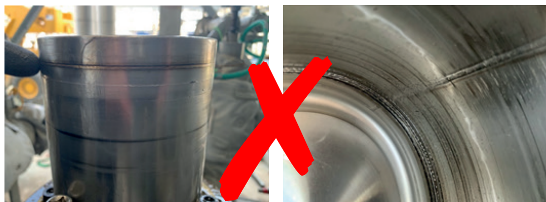
图 10: 安全壳 左: 整个壁厚遍布槽纹 右: 连续多个深槽纹
