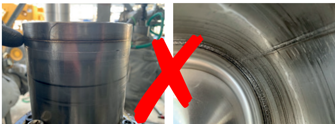
图 13: 安全壳 左: 整个壁厚遍布槽纹 右: 连续多个深槽纹
